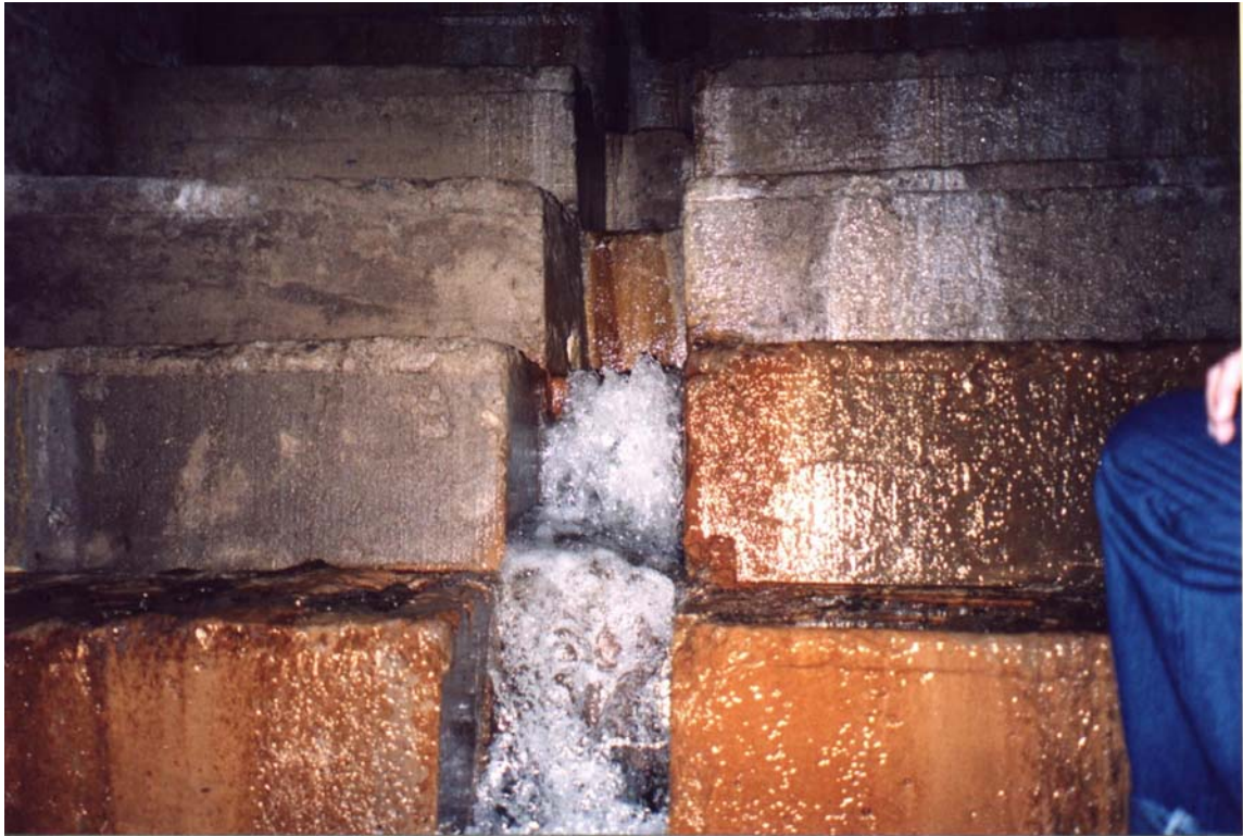
Fotografia 4: Artesianismo de um dos drenos da ombreira esquerda em 10/03/2004
