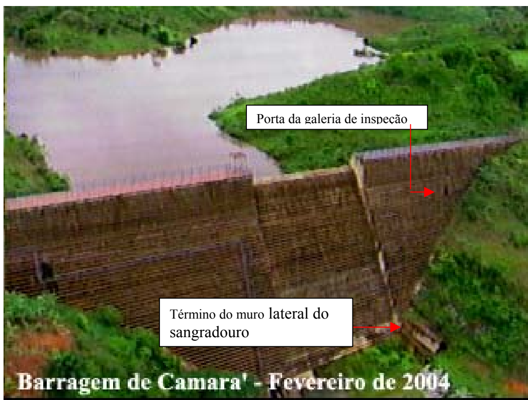
Fotografia 1: Camará em Fevereiro de 2004
