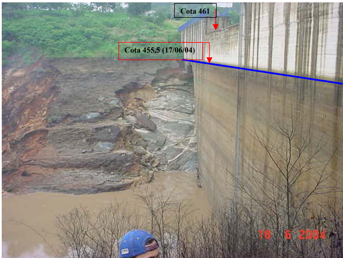
Fotografia 3: Vista de montante de Camará em 18/06/2004
